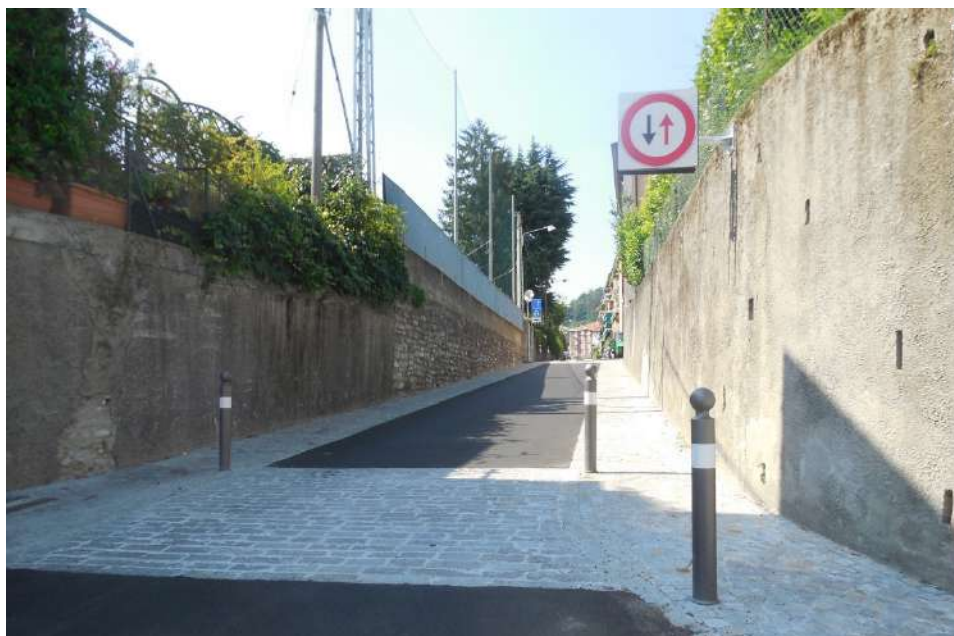
Figura 42 - Intervento di moderazione del traffico in via Lissi
